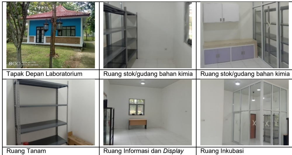
Gambar 3. Gambar Kondisi Laboratorium Pasca Pembangunan
