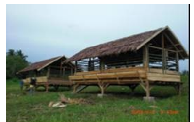
Bangunan kandang Kambing dalam area Demfarm Kambing
